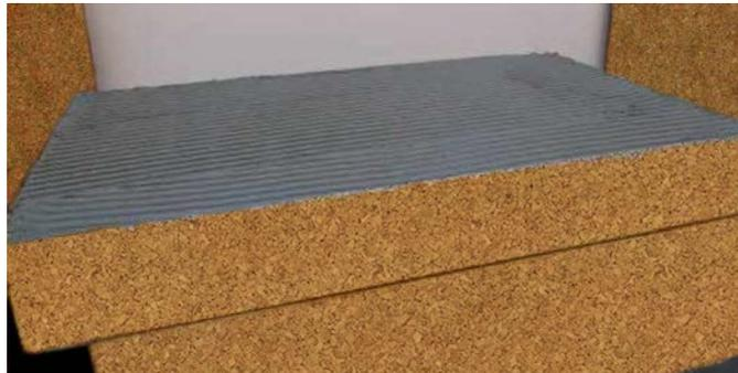
In entrambi i casi, la malta non deve essere applicata sulla superficie laterale del pannello, per garantire la continuità e la perfetta aderenza dell'isolamento ed evitare l'insorgenza di ponti termici. Affinché l'incollaggio sia efficace, è necessario che il collante-rasante penetri tra i granuli superficiali del pannello.
