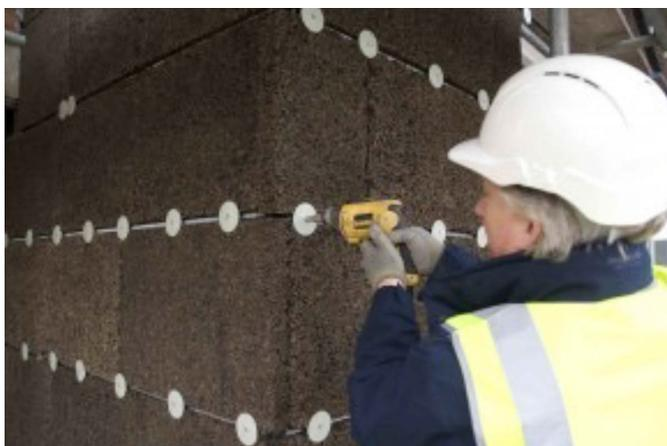
I tasselli certificati ETAG devono essere concepiti specificatamente per sistemi a cappotto termico e la tipologia varia a seconda del tipo di supporto. I tasselli vanno applicati dopo l'indurimento della malta, in numero variabile in funzione delle caratteristiche del supporto, dell'altezza dell'edificio e degli agenti atmosferici. Lo schema di fissaggio prevede due varianti: a T e a W. Prevedere circa 7 tasselli a metro quadrato.
