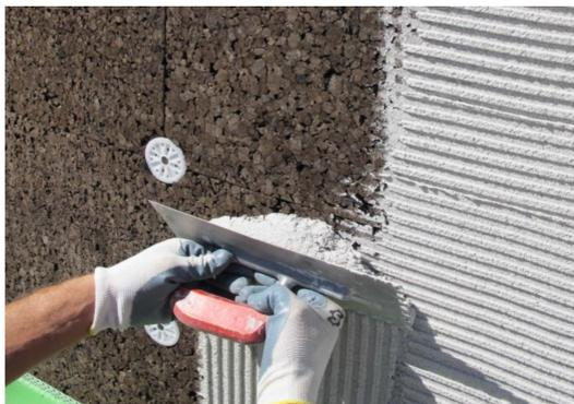
La rete di armatura ha la funzione di sopportare le tensioni che si generano nello strato di rasatura a causa degli sbalzi termici e microterremoti: è indispensabile per prevenire la formazione di fessure nell'intonaco. La rete, deve essere specificatamente concepita per sistemi a cappotto e deve essere costituita da fibra di vetro resistente agli alcali.
